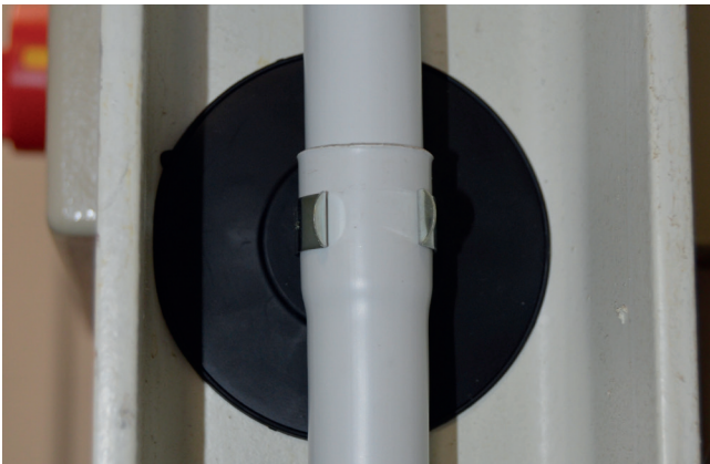
Befestigung von Rohren direkt an Stahlträgern
